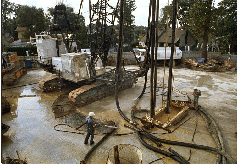
FIG. 1.13 – Creusement de parois moulées avant l'excavation du puits de la Place Berthet sur le chantier de l'A86 (Doc. Socatop 2001)
