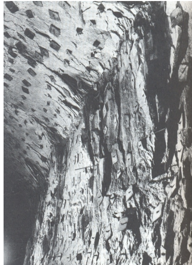
FIG. 1.12 – Ecaillage des parois du tunnel du Mont-Blanc lors de sa construction. Remarquer la forte densité de boulonnage.
