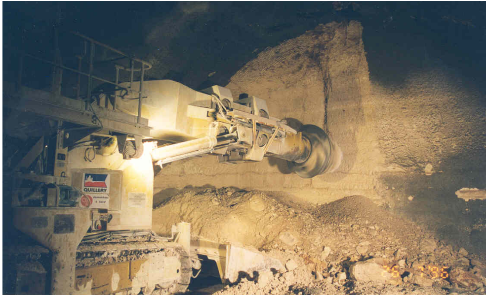
FIG. 1.5 – Machine à attaque ponctuelle sur le tunnel de Tartaiguille.
