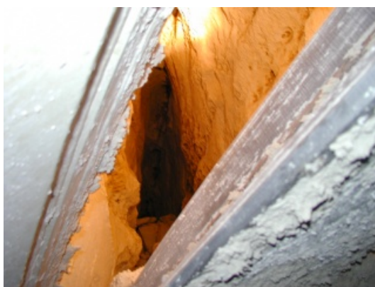
FIG. 1.1 – Méandre d'origine karstique photographié à travers la roue de coupe du tunnelier de l'A86 (Région parisienne, Socatop 2002)
